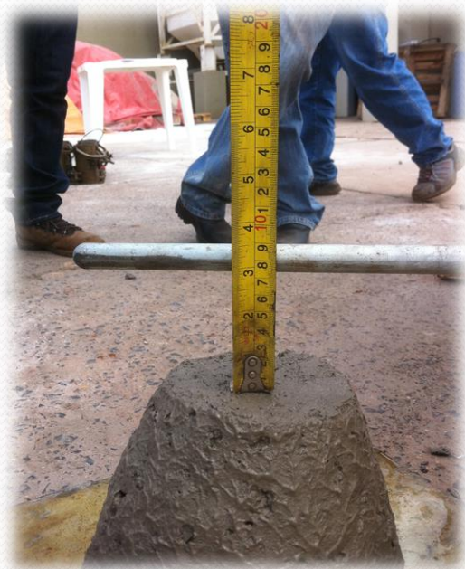
SLUMP ADEQUADO PARA LANÇAMENTO E ACABAMENTO
