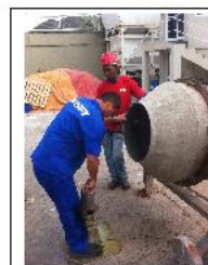
Ensaio de Slump
