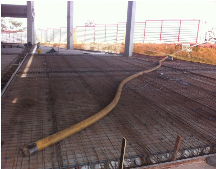
VERIFICAÇÃO DAS ARMADURAS
